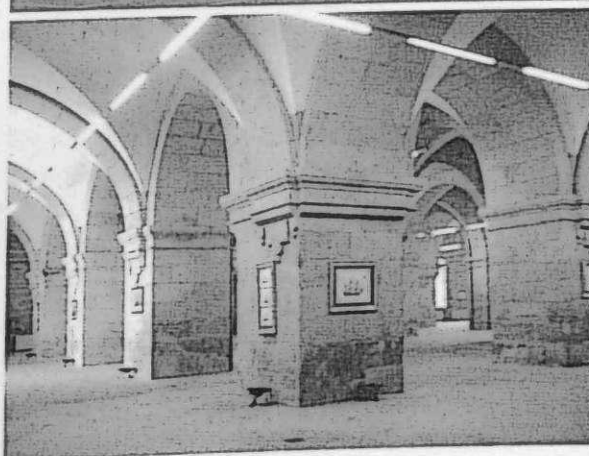
Exterior e interior da Sala de Armas.
